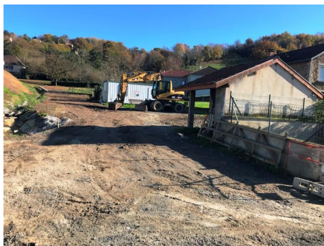
Emplacement parking du « Bout du Lieu »
