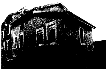
Rénovation maison Fleys
